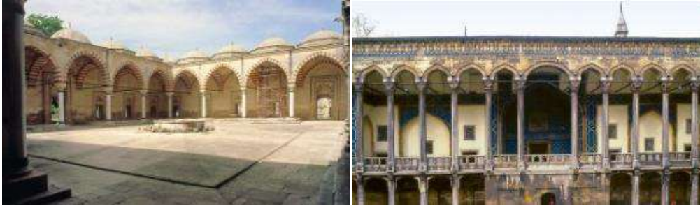
Şekil 5. Edirne Üç Şerefeli Camii'nin avlu revakları, Şekil 6. Çinili Köşk giriş cephesindeki revak (Mülayim islamansiklopedisi.org.tr/revak)
