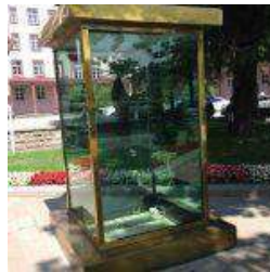
Şekil 24. İç İşleri Bakanlığı Protokol Nöbetçi Kulübesi Kurşungeçirmez cam ve pirinç imalat (2n-cam.com/)
