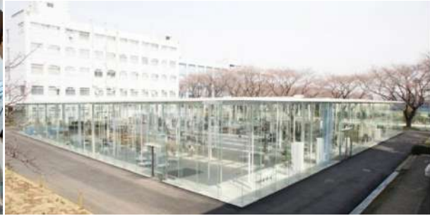
Şekil 16. DZ Bank Binası/Berlin –Mimar Frank Gehry (arkitektuel.com/) Şekil 17. Tokyo'da yer alan Kanagawa Teknoloji Enstitüsü, 2 bin metrekarelik ve tek bir oda. Sadece beyaz cam paneller ve değişen boyutlarda ve şekillerde çelik sütunlardan oluşan yapı (emlakwebtv.com/)
