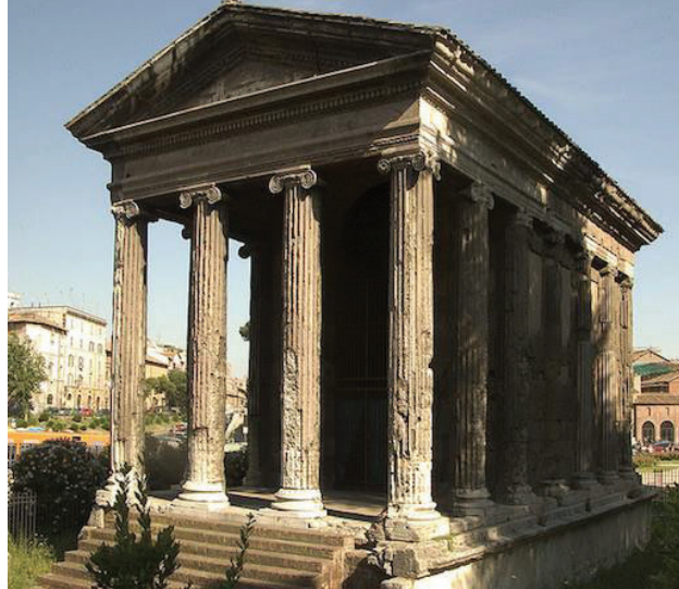
Şekil 3. Portunus Tapınağı (daha önceleri Fortuna Virilis olarak bilinirdi), MÖ yaklaşık 120-80, Roma, traverten ve tuf, sıvası binayı Yunan mermeri gibi göstermiştir(tr.khanacademy.org/)
