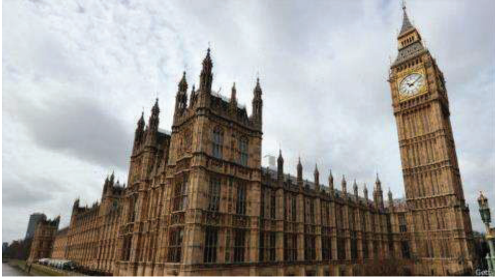
Şekil 7. İngiltere Parlamento Binası (yapi.com.tr/)
